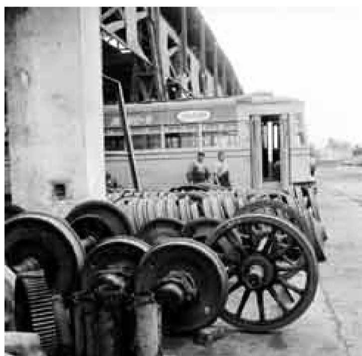
CERCA DEL FIN. Los vagones y las piezas empiezan a llenar los depósitos.
