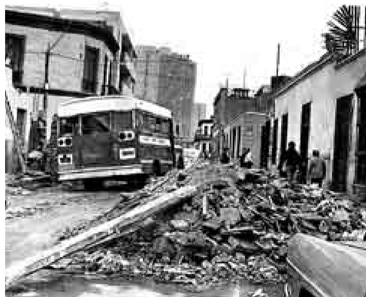
DAÑOS. Los terremotos de la década del setenta revelaron los riesgos a los que están expuestos algunos sectores de Lima por el suelo inestable.
